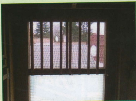
Pletivové okno s latkami (cca 5 cm od seba) vylučuje poranenie pazúrikov holubov (zlozenie) a taktiež znehodnotenie peria.
